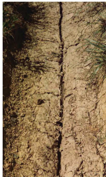
Longitudinal crack
